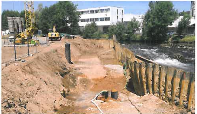
Oben: Schon im Bau lässt sich erkennen, wie die Fische später den Fischpass nutzen können. Große Steine verlangsamen die Strömung und ermöglichen den Aufstieg.
