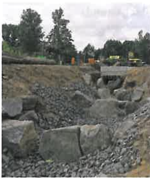
Oben: Schon im Bau lässt sich erkennen, wie die Fische später den Fischpass nutzen können. Große Steine verlangsamen die Strömung und ermöglichen den Aufstieg.
